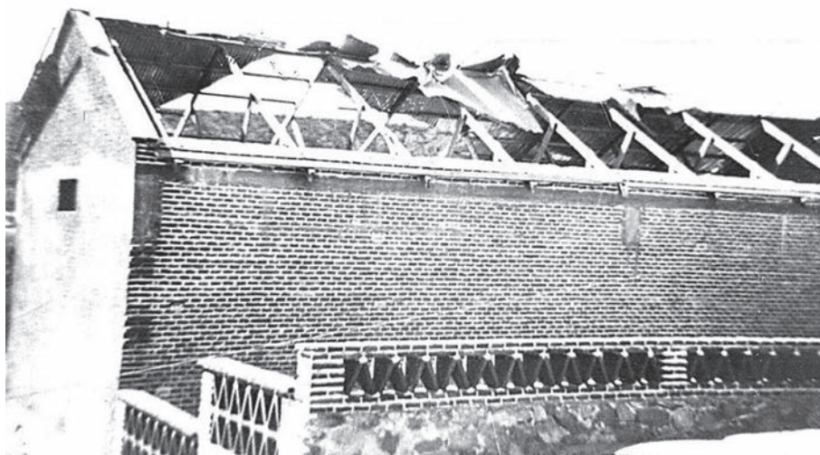
Afectaciones en el edificio de la Logia Faro del Sur de San José del Cabo, tras el huracán del 3 de octubre de 1958 (fotografía: Raúl Villarino).
