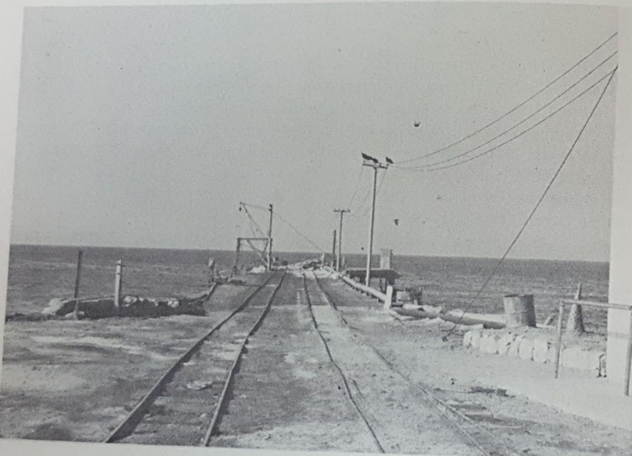
Una perspectiva del muelle de la compañía Salinas del Pacífico, S. A., en bahía Salinas, de isla del Carmen. La anchura de los carriles hace suponer que la trocha era de 30 pulgadas, (762 mm.). Era usado para cargar pequeños botes con sal los cuales la conducían a un barco que se encontraba anclado mar adentro.
