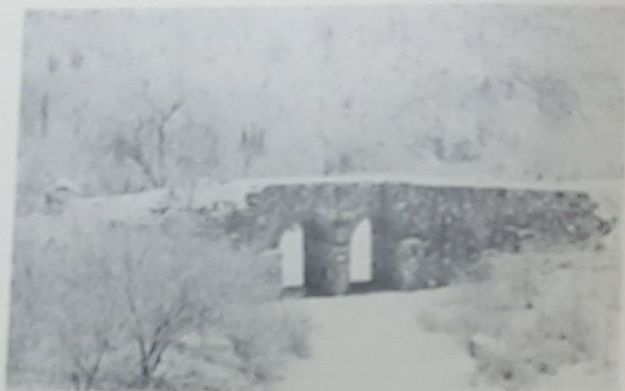
Uno de los dos hermosos puentes cuyos arcos conservan intacto su estilo arquitectónico, formaban parte de la ruta férrea de El Progreso Mining Company. En la actualidad pueden verse desde la carretera, al noroeste de El Triunfo.
